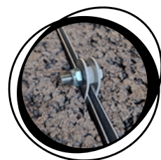
Par bride et goupille sur "oreilles d'association"
