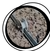
2. Par bride et goupille, sur oreilles d'association
