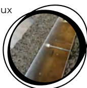
2. Par bride et goupille, sur oreilles d'association
